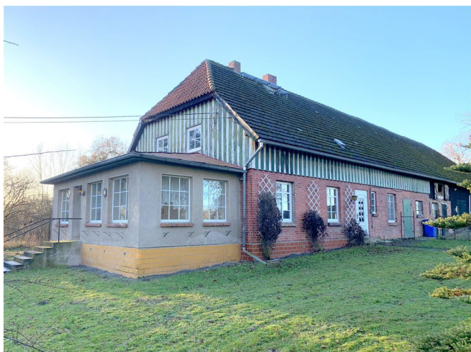
2 Anbau und Front
